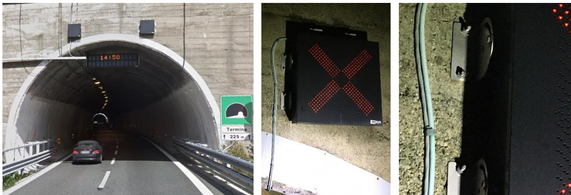
Figura 24 - Foto pannello Freccia/Croce installato sulla parete del portale di galleria.
