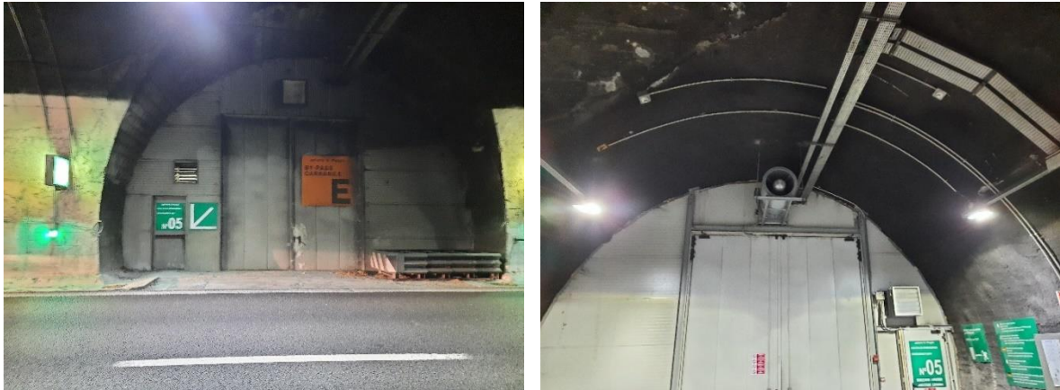
Figura 15 - A12 galleria Giovanni Maggio sx – Foto tamponatura bypass n°5, prospetto esterno (a sinistra) e prospetto interno (a destra).
