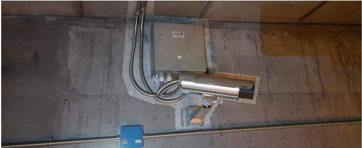
Figura 31 - Foto telecamera con cassetta di derivazione (NON SONO DI COMPETENZA DELL'ISPETTORE IL CORPO TELECAMERA E LA CASSETTA DI DERIVAZIONE).
