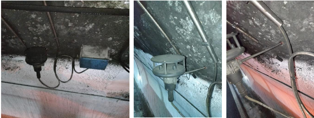
Figura 19 - Foto Anemometro (a sinistra) e particolare ancoraggio (al centro e a destra).
