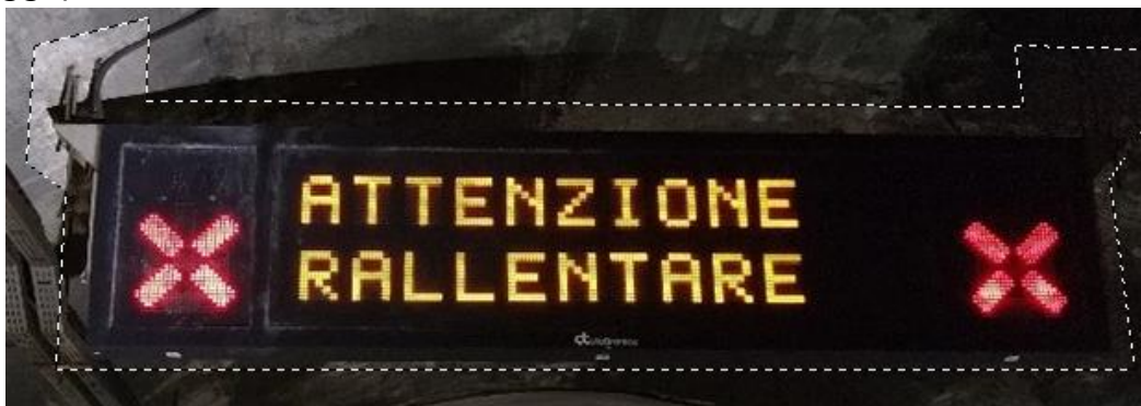
Figura 11 - Foto Pannello a Messaggio variabile e Freccia/Croce (NON È DI COMPETENZA DELL'ISPETTORE IL CORPO DEL PANNELLO PMV) .
