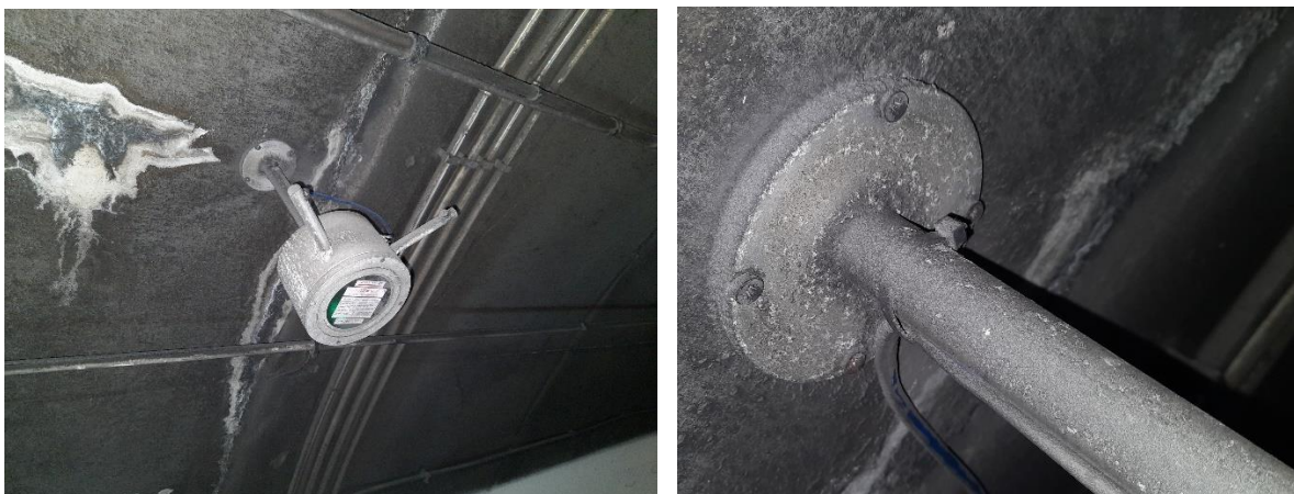
Figura 18 - Foto Anemometro (a sinistra) e particolare ancoraggio (a destra).
