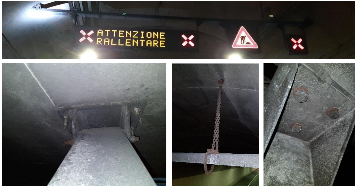
Figura 12 - Foto PMV e F/C (in alto), piastra di ancoraggio alla volta (in basso a sinistra), catena di sicurezza (in basso al centro), giunzione della struttura di sostegno PMV alla trave (in basso a destra).
