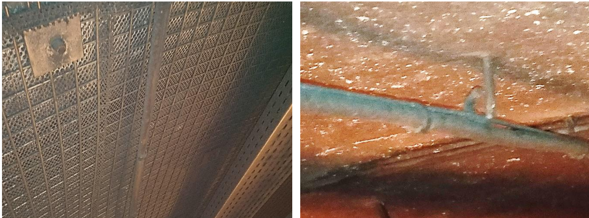
Figura 7 - Foto cavo antenna GSM, fissato su tesata d'acciaio ancorata in volta con occhielli metallici.
