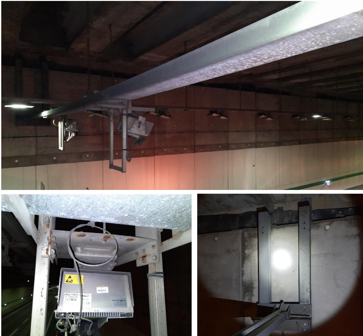
Figura 33 - Foto trave impianto Tutor (in alto), rilevatore di velocità (a sinistra), particolare ancoraggio trave (a destra).
