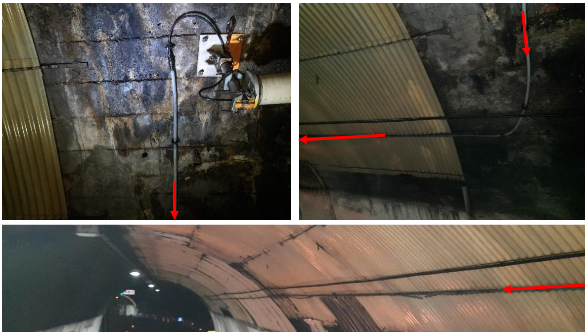
Figura 8 - Particolare cavo antenna GSM, fissato in volta su tesata d'acciaio. Partenza da antenna (in alto a sinistra) e percorso fino allo sbocco di galleria (in alto a destra e in basso).
