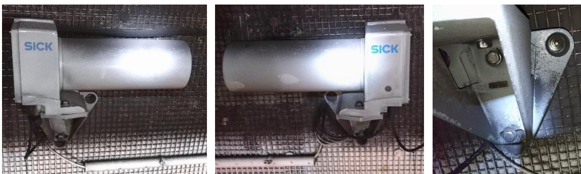
Figura 21 - Foto rilevatore CO-OP, emettitore/ricevitore (a sinistra e al centro) e particolare ancoraggio (a destra).
