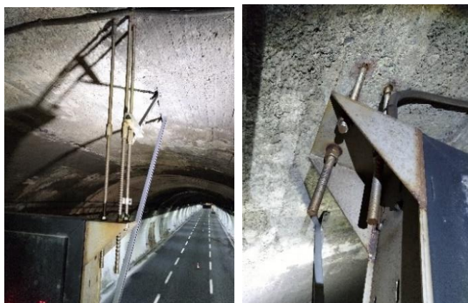
Figura 10 - Foto PMV dettaglio ancoraggi.
