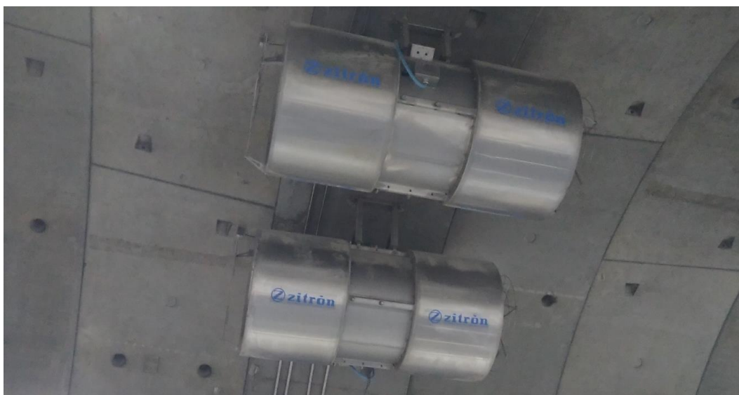
Figura 13 – Foto coppia di acceleratori in galleria.
