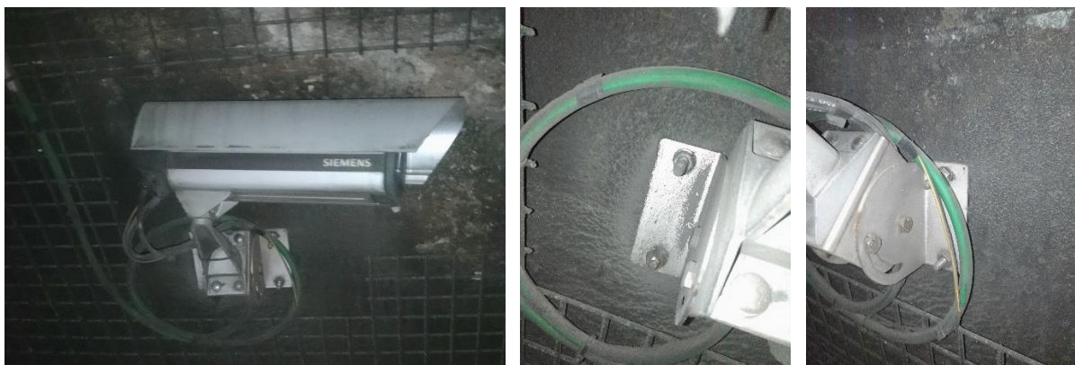
Figura 30 - Foto telecamera (a sinistra) e particolare ancoraggio (al centro e a sinistra).
