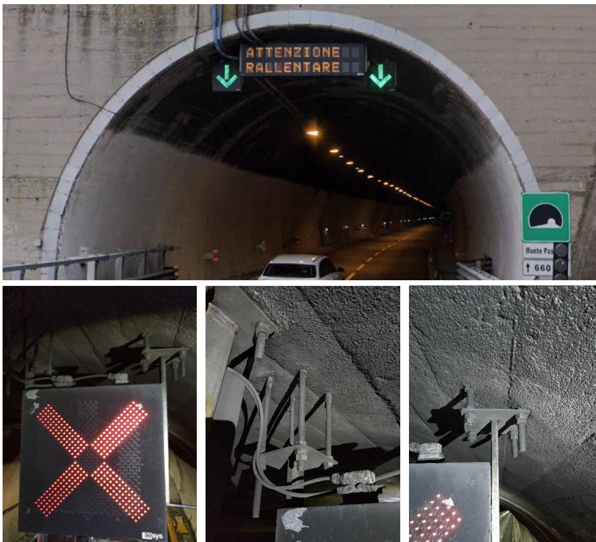
Figura 25 - Foto pannello Freccia/Croce installato in volta.
