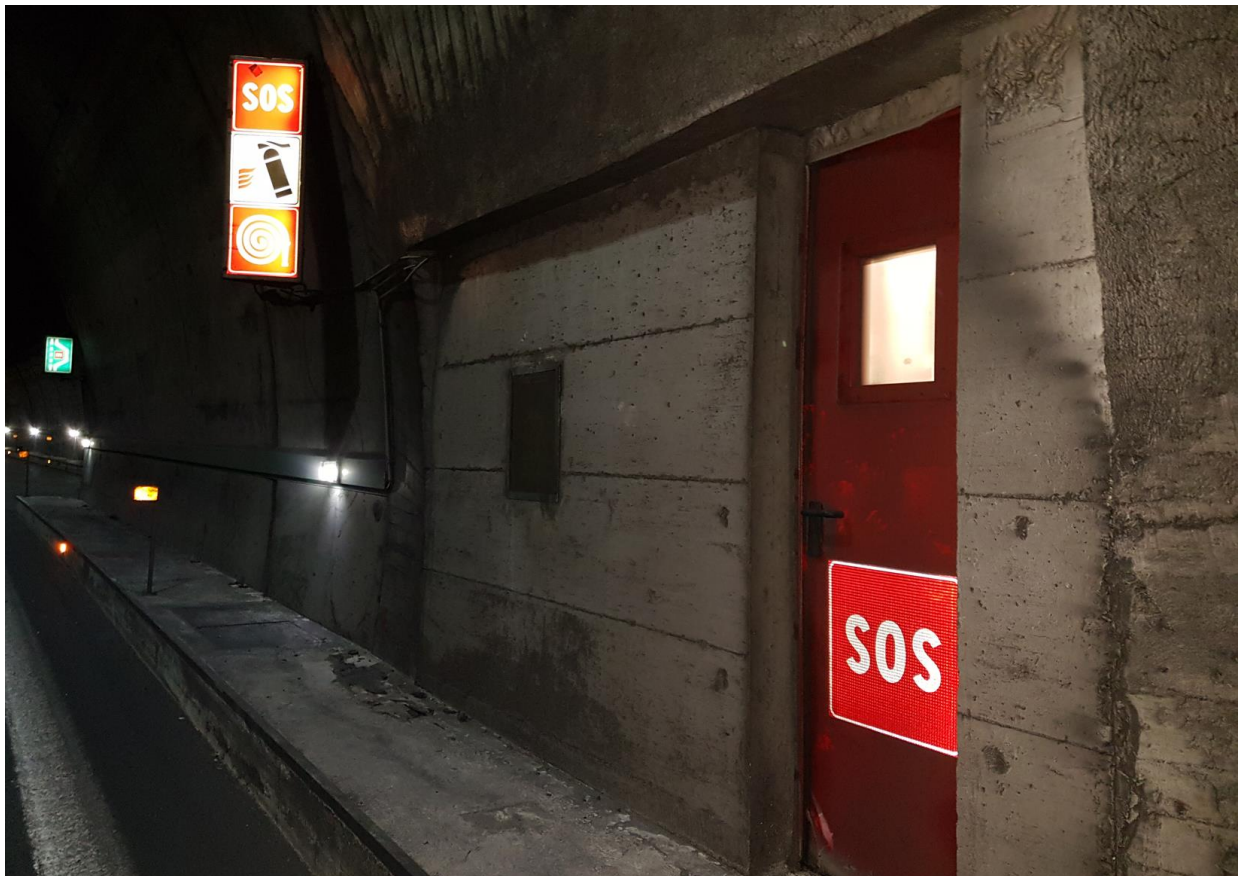
Figura 27 - Nicchia SOS accessibile da porta di separazione con il vano traffico.
