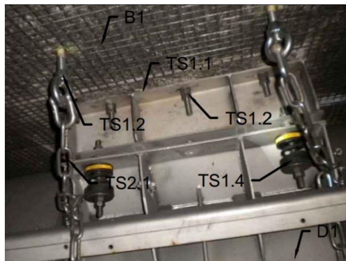
Figura 37 - Esempio di schema strutturale: Foto struttura di sostegno ed elementi di connessione ventilatori.
