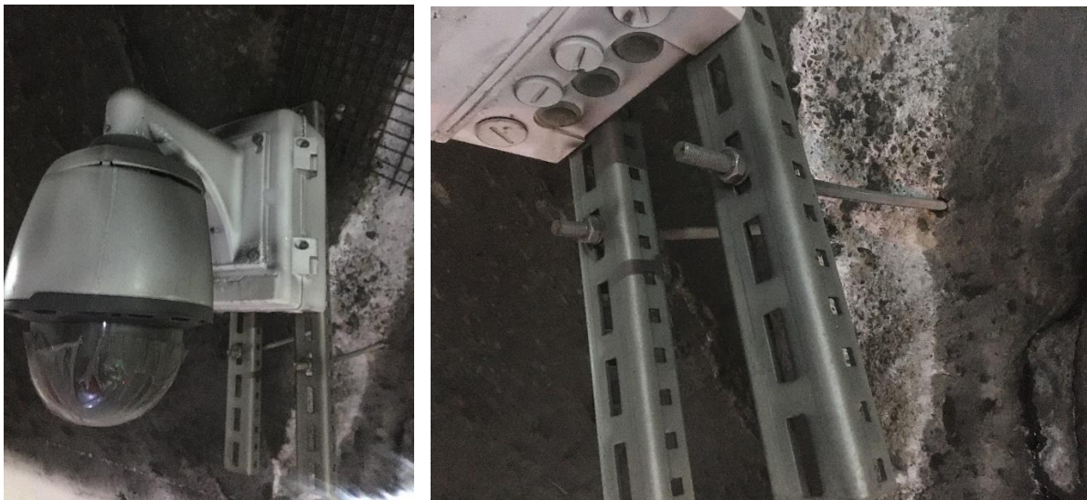
Figura 32 - Foto telecamera DOME (a sinistra) e particolare ancoraggio (a destra).
