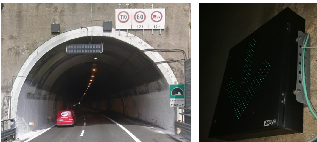
Figura 23 - Foto pannello Freccia/Croce installato sulla parete del portale di galleria.
